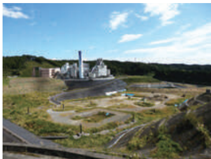
日の出町ニッ塚廃棄物広域処分場
